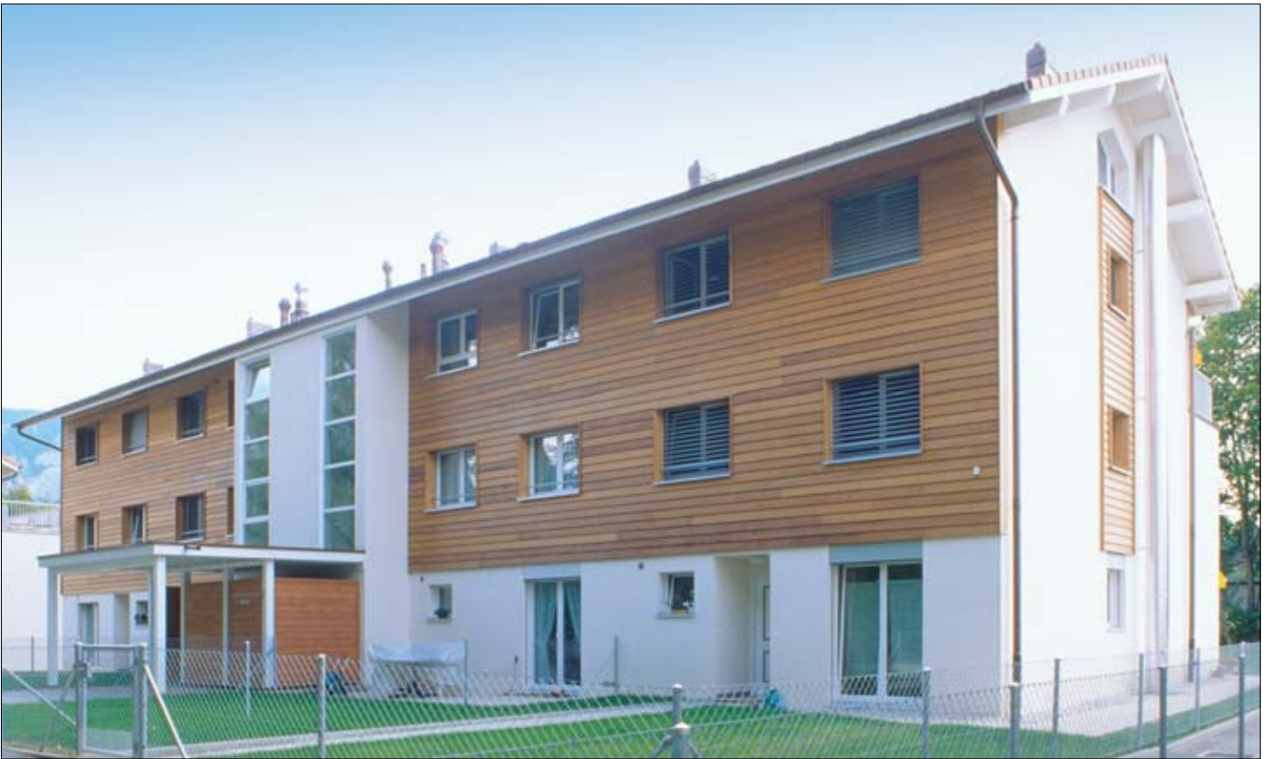
Unité comprenant quatre appartements en duplex sur rez et attiques au 2ème et sous combles.
