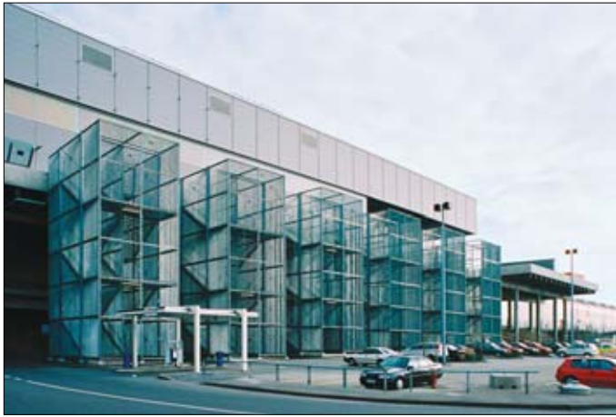
Escaliers de secours côté Aéroport
