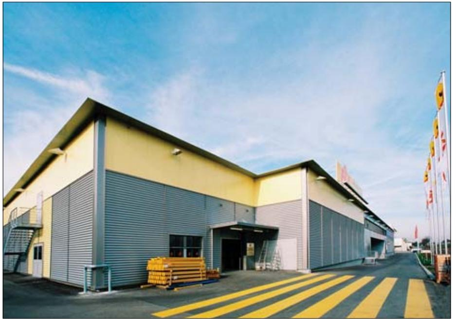
en tôle "Holorib" et en panneaux sandwich isolés, dotés d'un parement extérieur en tôle sinus.
