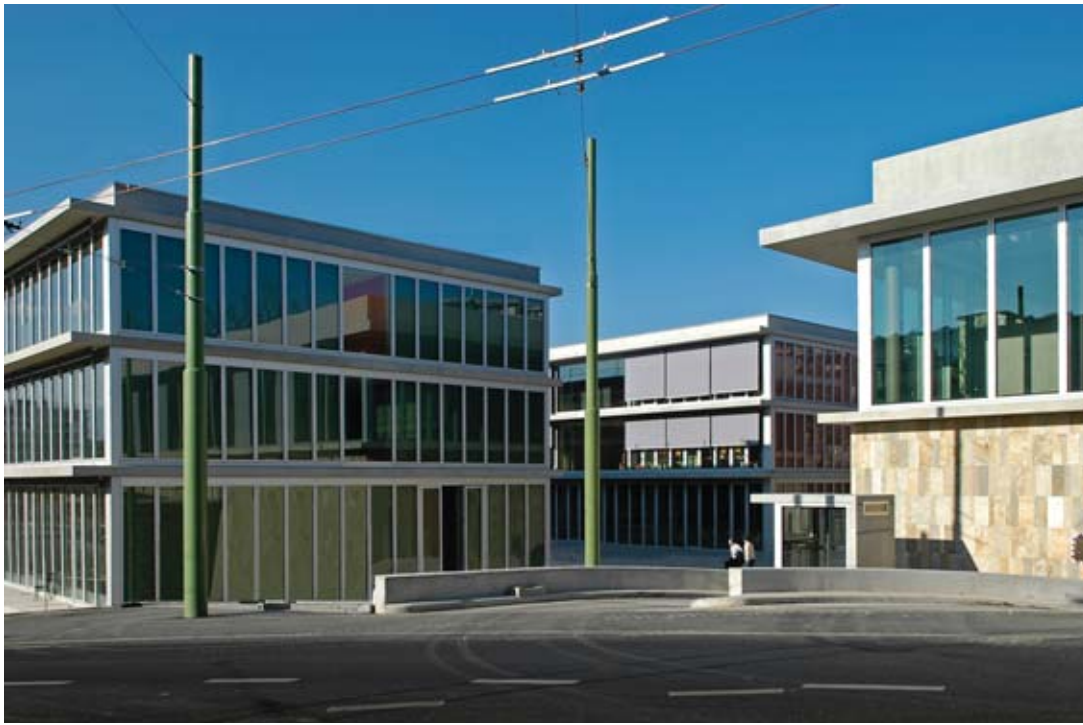
Vue sur les trois bâtiments
